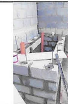
Foto 5: Trabajo construcción pila de concreto.
