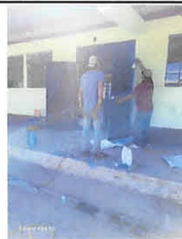
Foto 4: Proceso del trabajo mantenimiento a portones interiores de las aulas.
