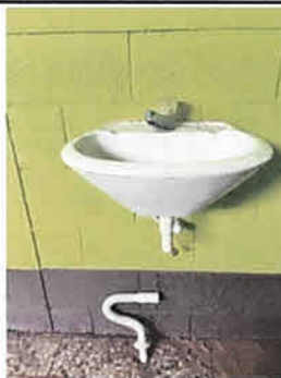
Foto 3: Proceso de trabajo cambio de accesorios lavamanos.
