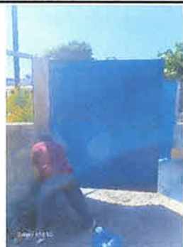
Foto 1: Proceso del trabajo mantenimiento al porton principal.
