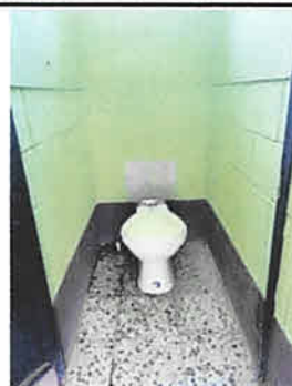
Foto 2: Proceso cambio de accesorios a los servicios sanitarios.
