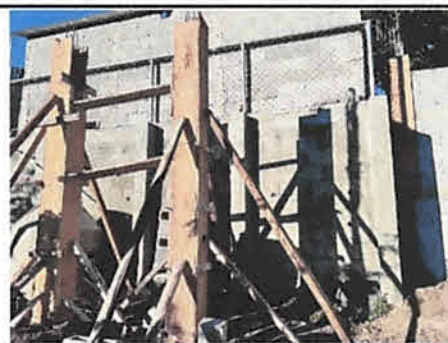
Foto 6: Trabajo implementación base fija de metal con columnas de concreto donde colocarlo.
